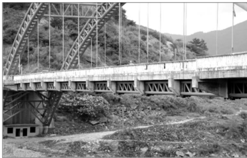
图 7 加固改造后的石潭溪大桥(摄于 2008 年 3 月)
